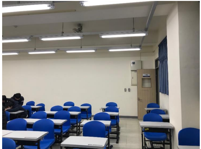
教室牆面粉刷改善
